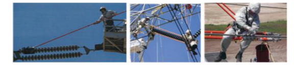
<해외 HVDC 가공선로 유지보수 작업 예시>
